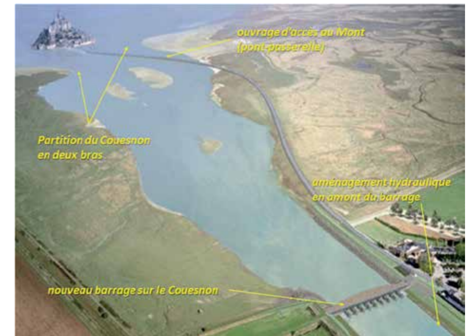
Figure 2 Aperçu des travaux réalisés sur la partie terminale du Couesnon dans le programme de restitution du caractère maritime du Mont-Saint-Michel.
