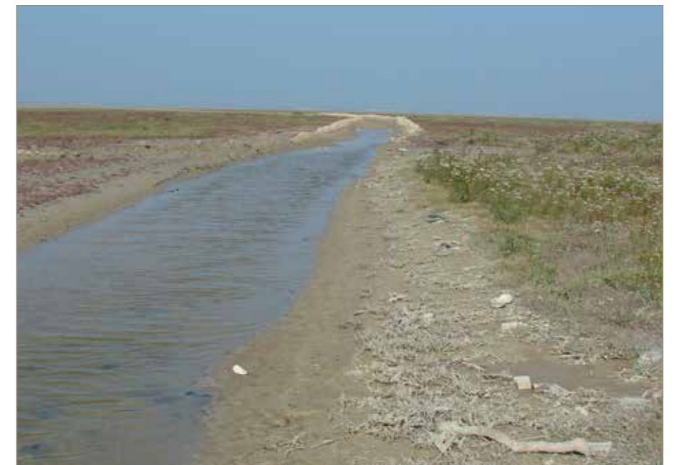
Photo 9 - Chenal creusé pour l'entrée d'eaux marines dans les mares de chasse du Fort-Vert, à l'ouest du Banc à Passe-Pierre (septembre 2007). Cliché : Benoît Toussaint
